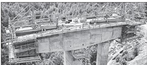
Slika 17. Konzolni-balansni postupak betoniranja grednih mostova
